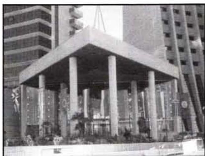
Entrada del Hotel Bali
